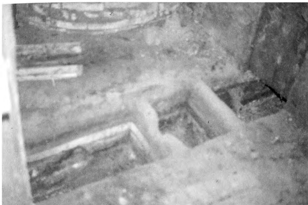
Lám. 13. Arquetas de desaguadoiro do lagar de Forcarei.
