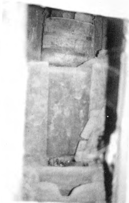
Lâm. 6. Taco e fronte do pío do lagar de Forcarei.
