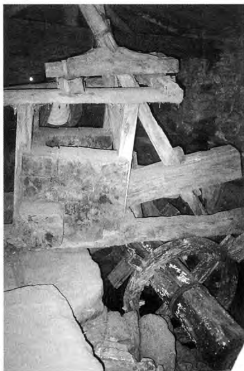
18. Vista desde a parte do rodicio do batán central (o reconstruído en 1986) do Mosquetín. Un pequeno arranxo permitiríalle volver funcionar de novo
