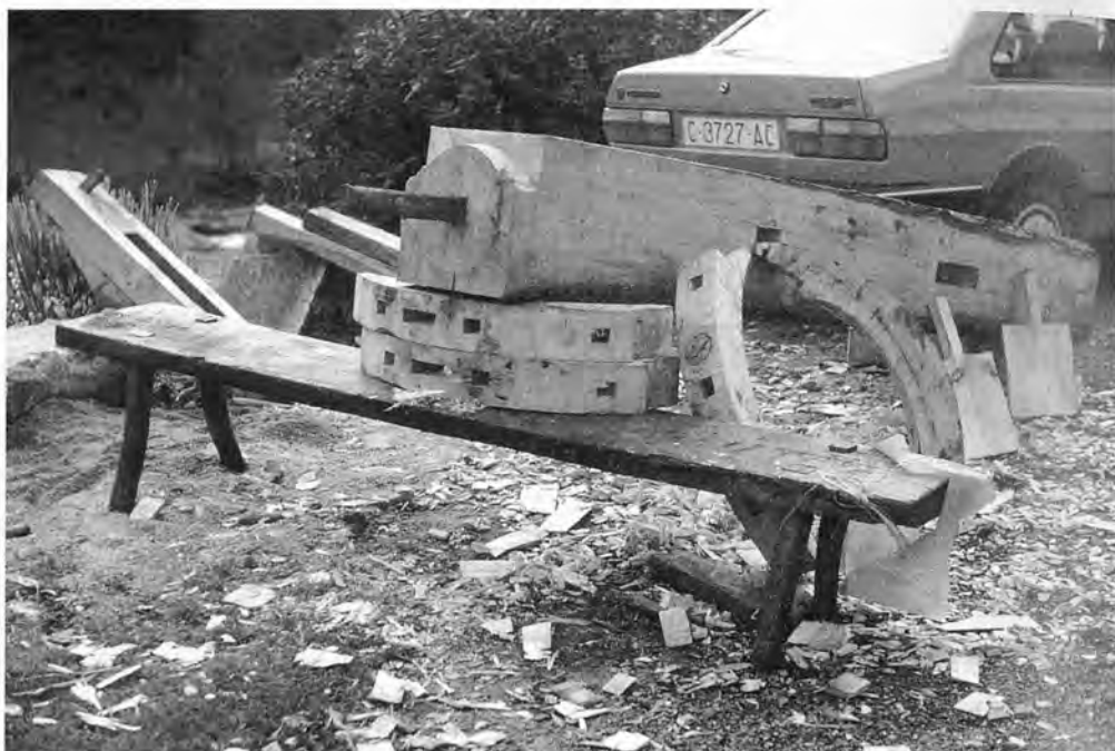
7. Reconstrucción in situ do batán central en 1985: o eixe, as pezas do rodicio, os xugos.
