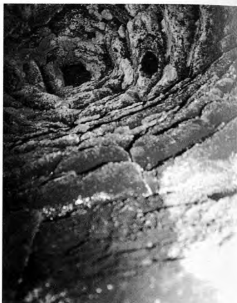
Interior da "capilla" do forno (bóveda).
