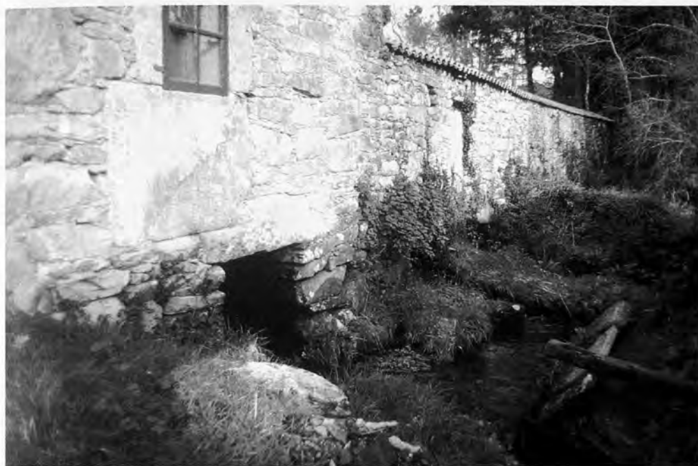
3. O edificio que acubilla ós tres batáns do Mosquetín e a dous muíños (en 1986).
