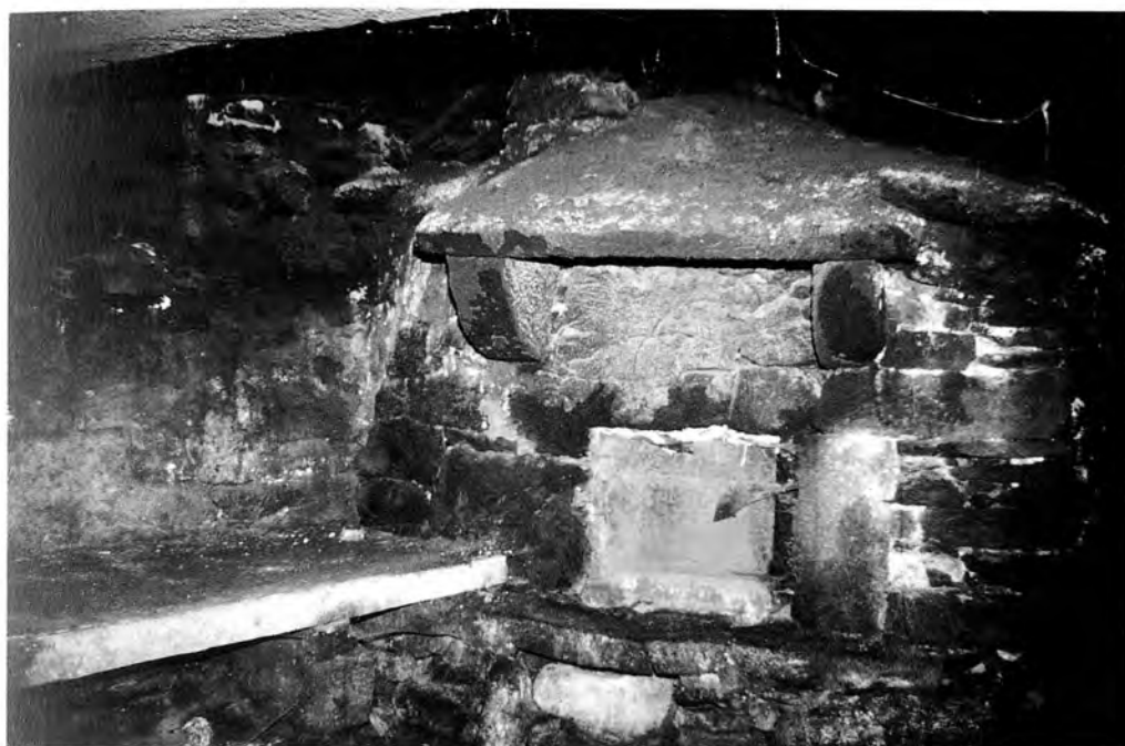
A "capilla" do forno e o taboleiro.
