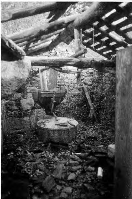
13. As inundacións de decembro de 1987 destruíron por completo este muíño do Mosquetín (edificio sur).
