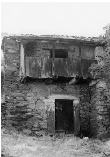
Casa con corredor protexido con táboas (Peranzais)
