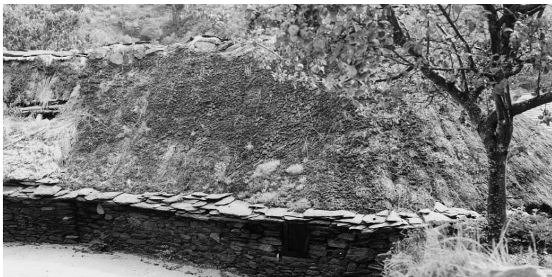
Dentro de moi poucos anos das construcións teitadas non quedarán máis que os muros (Cariseda)
