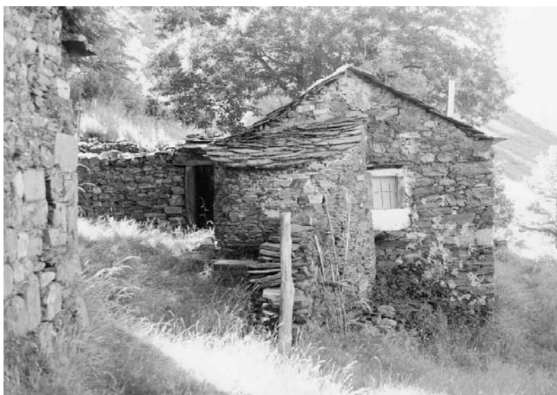
Forno exterior de planta circular (Prado)
