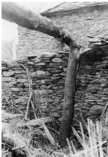
Un dos postes dunha palloza, sobre os que se asenta toda a armazón de madeira (Cariseda)
