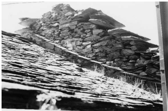
Lousas protectoras para que non escorra a auga polas paredes (Peranzais)
