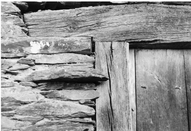
A pedra e a madeira foron dende sempre os únicos materiais constructivos, xunto coa cuberta de palla. Pormenor dunha porta (Peranzais)
