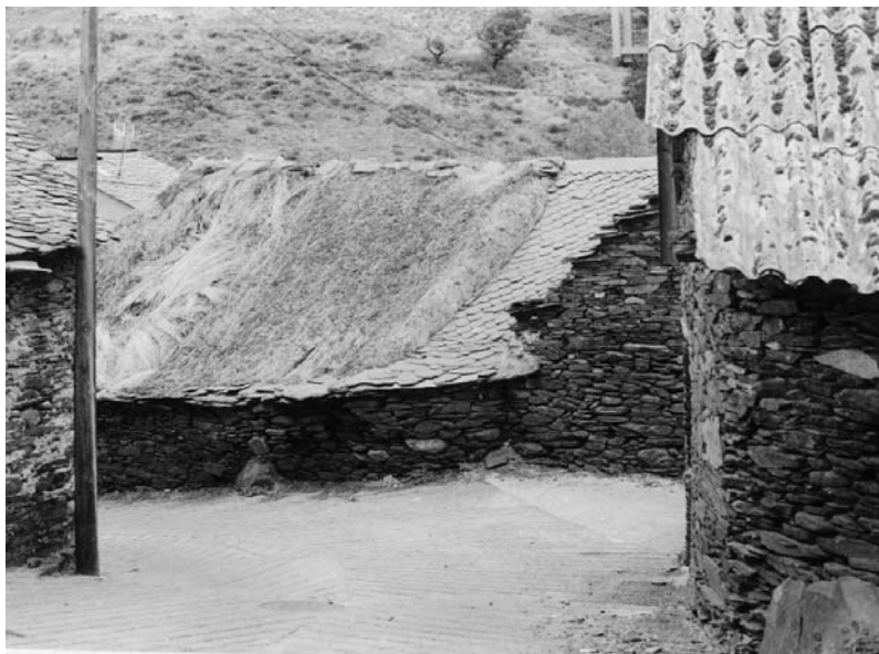
Nas últimas décadas conviviron tres cubertas: a de palla, a de lousa e a de fibrocemento (Cariseda)
