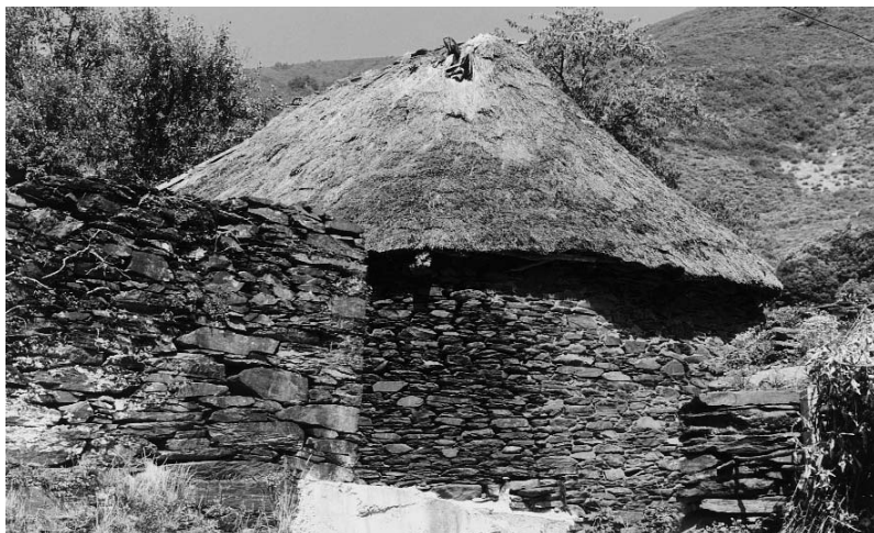
Ata as primeiras décadas do século XX a palla foi o material de cubrición máis corrente en todo o val (Cariseda)
