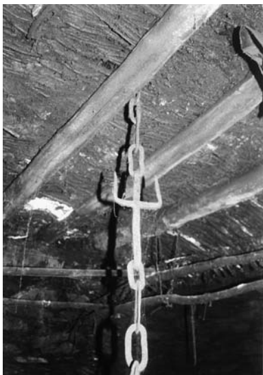
Canizo de vergas de salgueiro embarradas -con terra- e preganza nunha palloza de Cariseda
