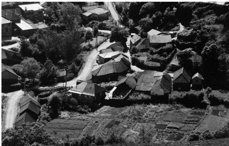
Palleiros de Fresnedelo: a palla foi substituída por fibrocemento.
