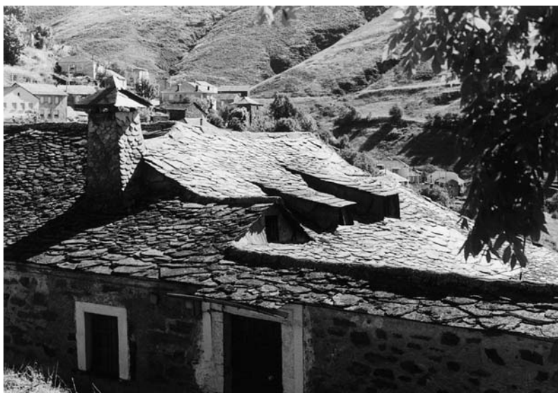
A lousa, como vai suxeita sobre madeira, permite facer formas caprichosas (Trascastro)
