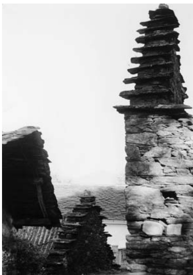
Unha das características das “casas de teito” fornelas son os pinches dos penais rematados en escaleira (Peranzais)
